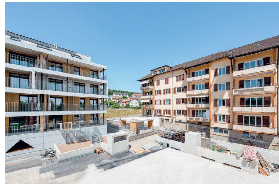
Gebäude vor und nach den Baumaßnahmen. Buildings before and after the construction measures.
