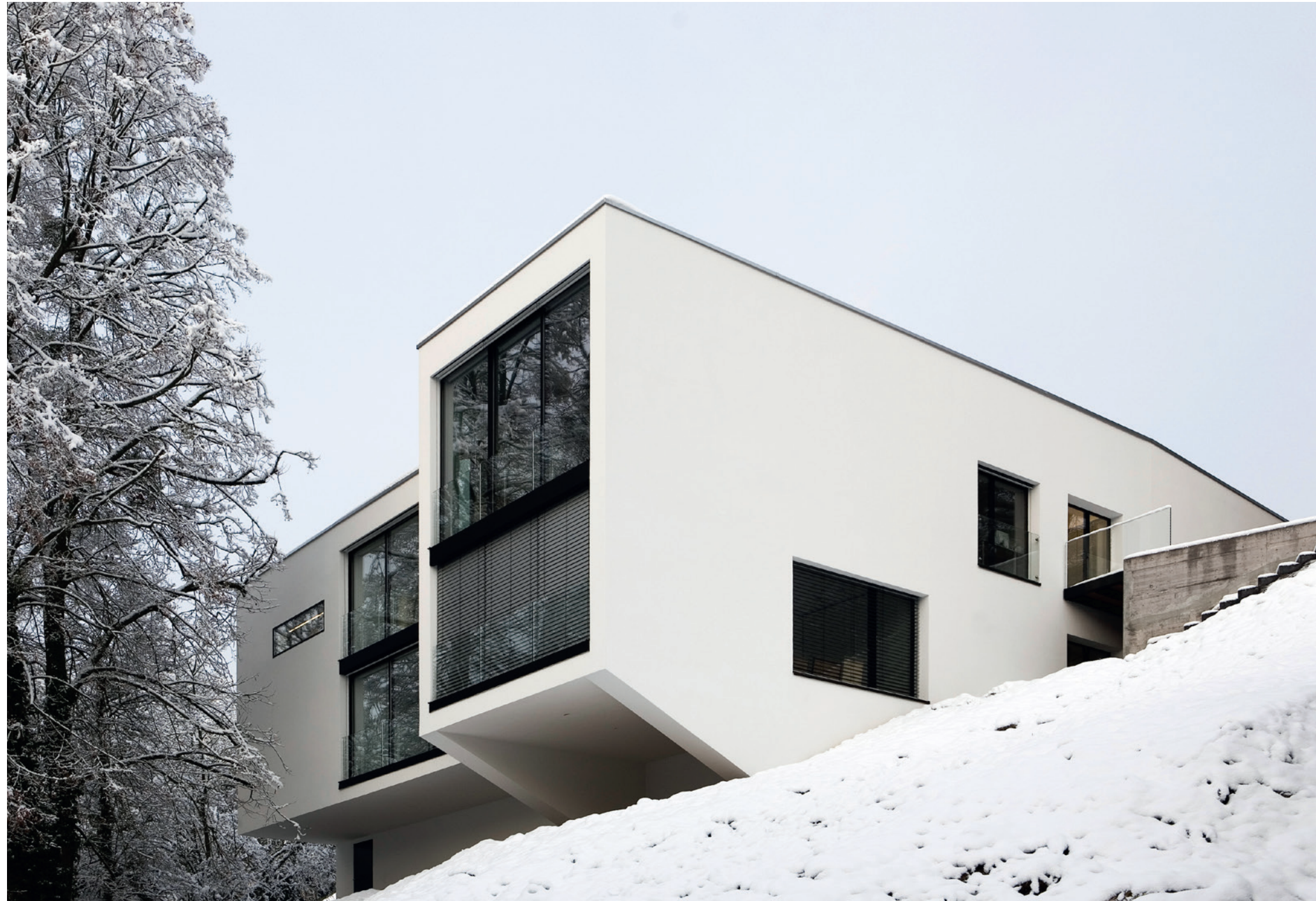
Aussenansicht der Südfassade.
