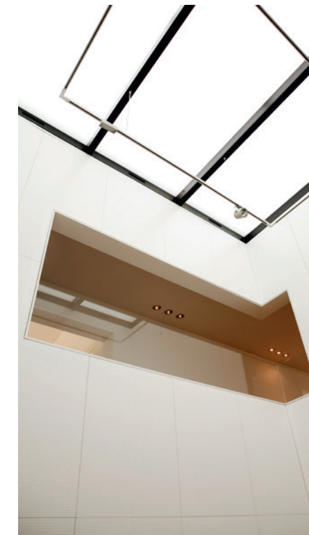
Die hohen Räume der Kunst-Galerie wurden mit Akustik-Wänden und spezieller Vorrichtung für das Aufhängen der Bilder errichtet.
