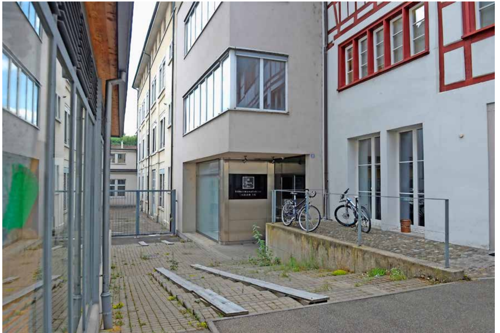
In der ehemaligen Jezler-Manufaktur beim Herrenacker in Schaffhausen sollen Wohn- und Arbeitsräume geschaffen werden.
