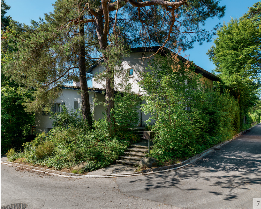
7 Von der Strassenseite her ist das zweistöckige Wohnhaus gut sichtbar. Um möglichst viel Gartenfläche zur Verfügung zu haben, wurde das Gebäude an den Rand des Grundstücks positioniert.
